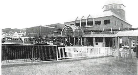
呉のフェリーターミナルと大和ミュージアム(左手)
